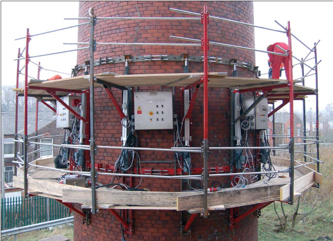
Wartungsbühnenverstellung über Schwerlastzylinder SLZ 90 Adjustment of the maintenance hoist by heavy duty cylinder SLZ 90
